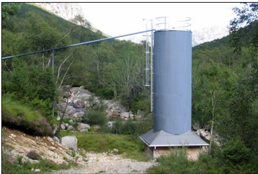
Bildet viser kalkdoserer i Vinddøla. Foto: BM Larsen
